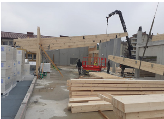
Travaux de rénovation du collège
