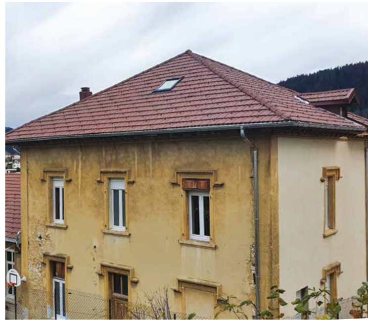
Nouveau toit de la MJC
